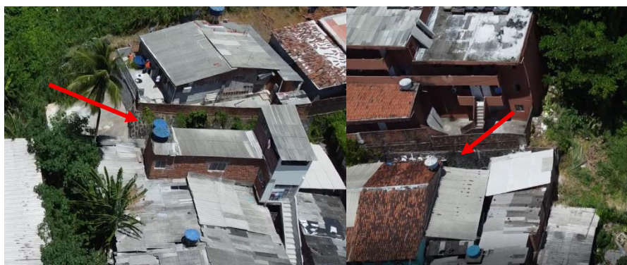
Figura 7 – Registros fotográficos de duas obras de contenções existentes na encosta. Fonte: Elaborado pelos autores
