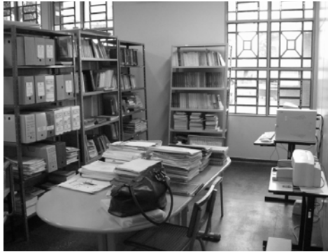
Figura 8. Laboratório de Análise Documental da UFRR. Incidência solar sobre o acervo e espaço de consulta inadequado
