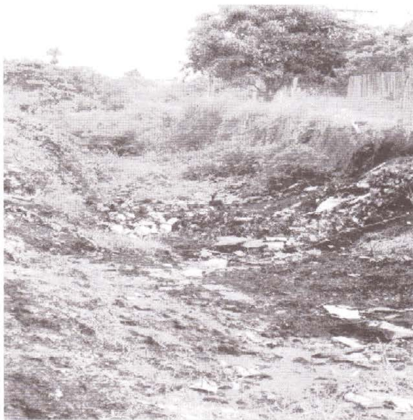
Fig. 02. Abertura de vala para escoamento superficial em bairros periféricos. Frequentemente esses valões estão entulhados de lixo que produzem chorume e são descarregados nas drenagens.
