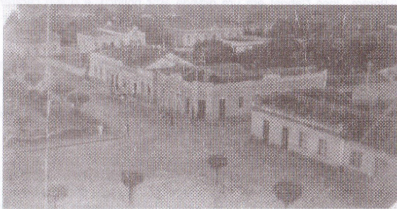
Figura 2-Trecho da Rua D. Margarida com a Floriano Peixoto-(1920?). As ruas barbarenses, como afirmamos acima, às custas das desapropriações e exclusões, já vinham sendo alargadas e retificadas desde 1885. Fonte: Arquivo Histórico da Fundação ROMI - Santa Bárbara d'Oeste.
