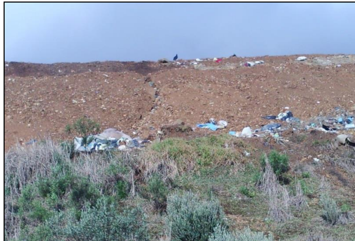
Figura 9 - Taludes definitivos sem cobertura vegetal.
