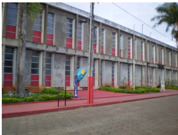
Figura 2 - Ausência de cesta para lixo em frente à Prefeitura Municipal, Bambuí/MG.
