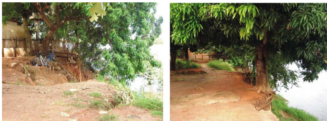
Figura 3 - Erosão laminar na área estudada e o fundo do lote 6 (Figura do lado direito) onde podem ser observadas as conseqüências da erosão marginal e o rio Paraguaí (Fonte: Silva, 2007).
