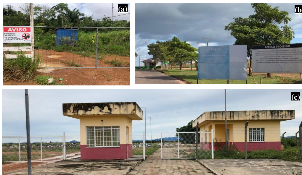
Figura 3 - Rol de entrada das áreas municipais de disposição de resíduos com isolamento físico e visual. (a) Alto Alegre/RR. (b) Boa Vista/RR. (c) Normandia/RR. Autores (2022).
