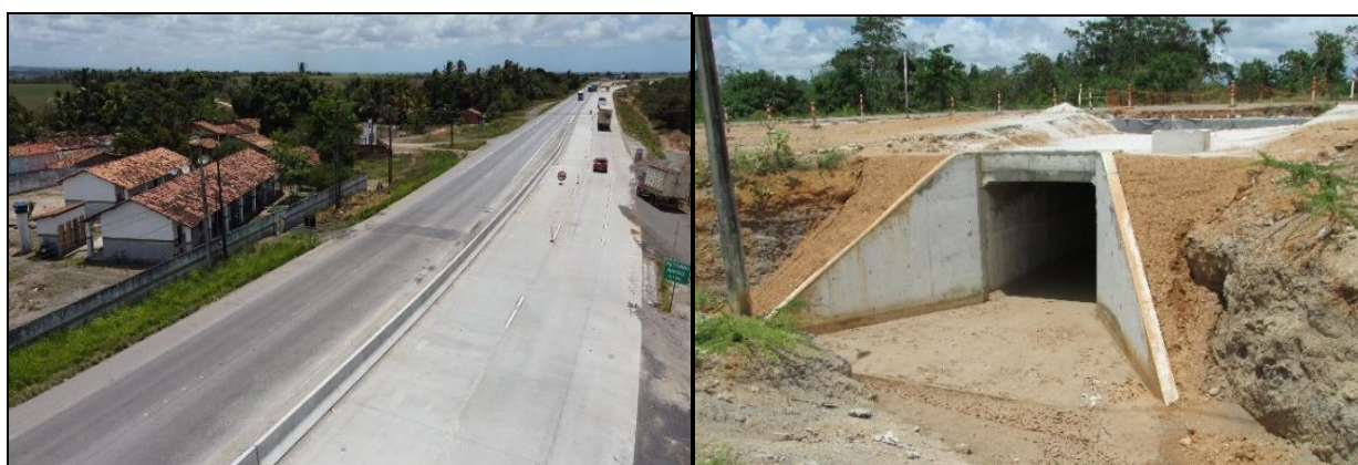
Figura 8 - Instalação de Passagem Inferior, Povoado Pirunga, Lote 1/SE. Fonte: Lima, Josiene Ferreira dos Santos, 2020.
