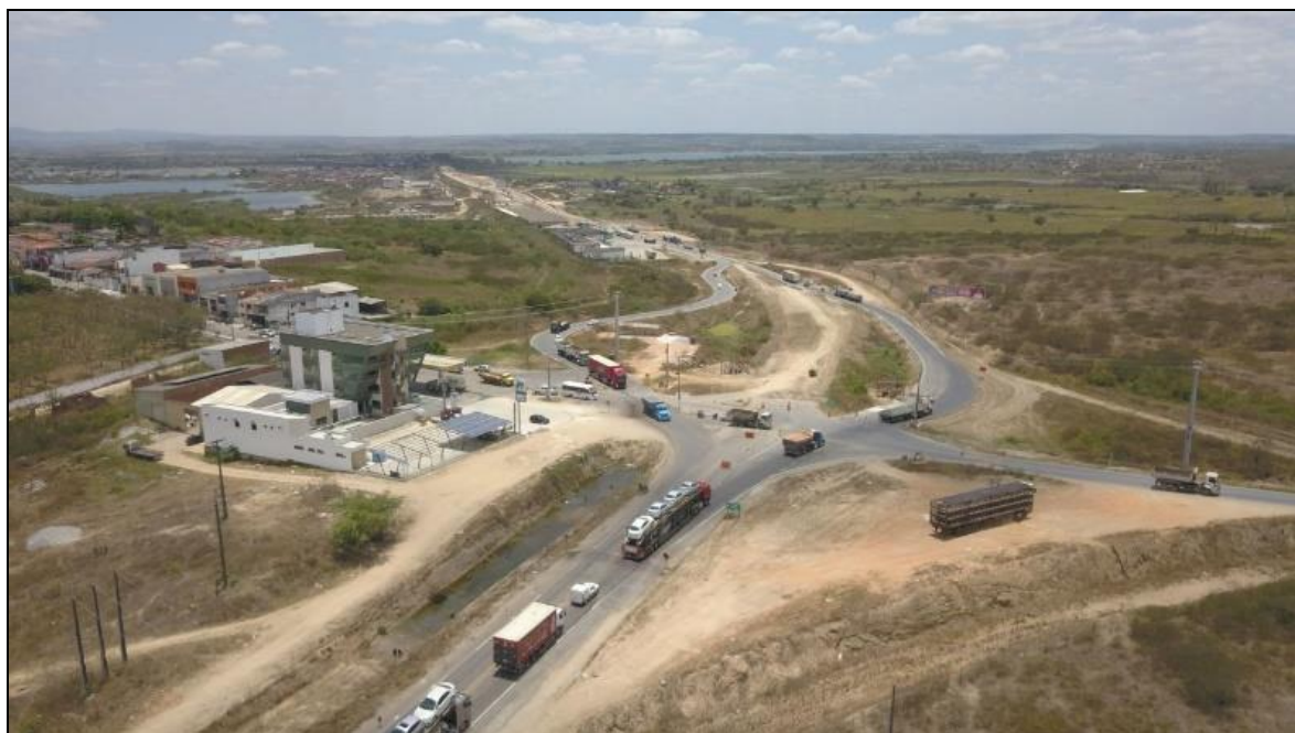
Figura 2 - Trecho da BR 101, Lote 1/SE. Fonte: Lima, Josiene Ferreira dos Santos, 2021.
