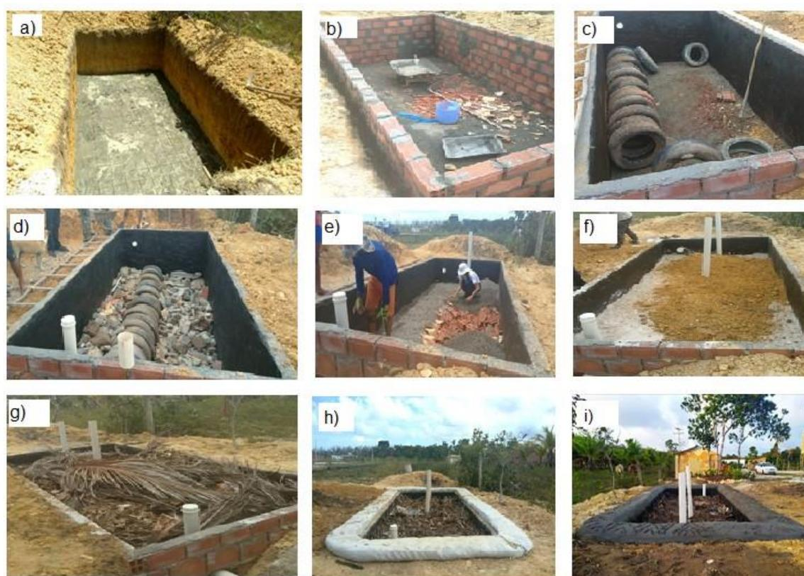
**Figura 2** – Etapas da construção da BET Modelo, onde: a) escavação do solo e início da impermeabilização da base; b) assentamento das paredes; c) impermeabilização das paredes e preparação para montagem da câmara de pneus; d) preenchimento da primeira camada com entulho; e) segunda camada com brita; f) terceira camada com areia e quarta com solo; g) cobertura com resto de poda; h) construção da proteção lateral da superfície e plantio das bananeiras (enterradas); i) BET finalizada.
