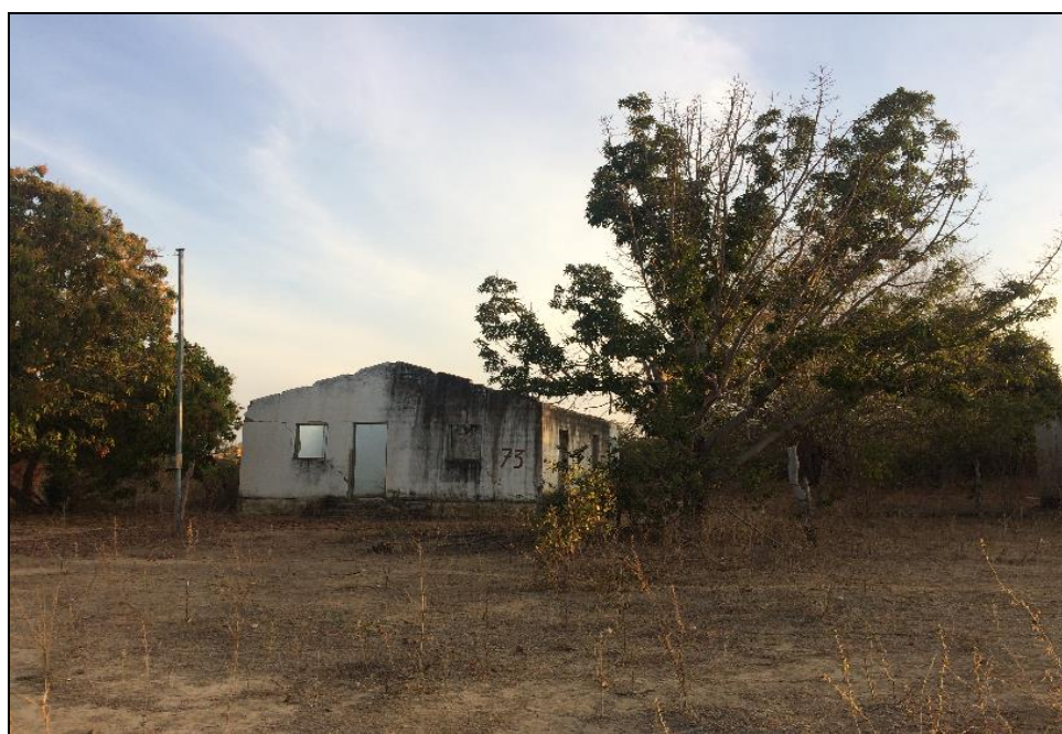
Figura 6 - Residência abandonada na comunidade Buritis. Fonte: MENDONÇA, D. S. (2018).
