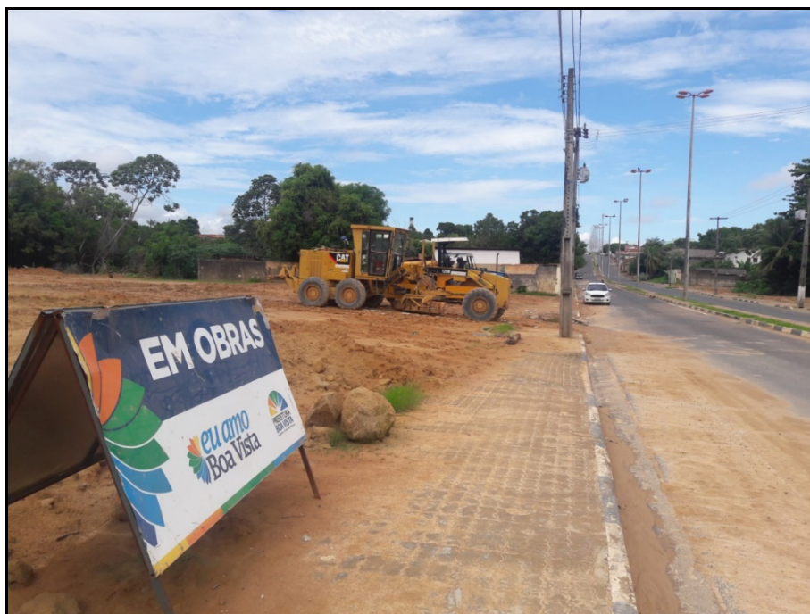
Figura 5 - Obras de canalização na Avenida Getúlio Vargas. Fonte: Acervo pessoal Pâmola Walter (2018).
