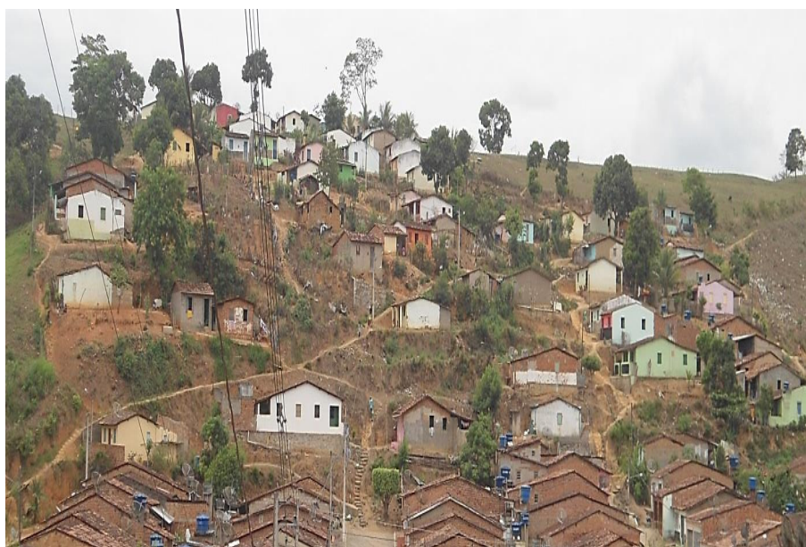
Figura 7 - Situação de risco de deslizamento no bairro Padre João de Barros Pinho em São José da Laje/AL Fonte: pesquisa aplicada (2016).
