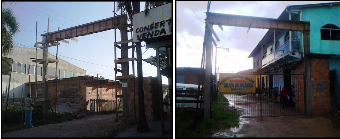
Figuras 5 e 6 - Entrada (pórtico) em construção com sua guarita e cerca. Este processo ocorreu na rua Silva Bragança, no quilometro oito da Avenida.
