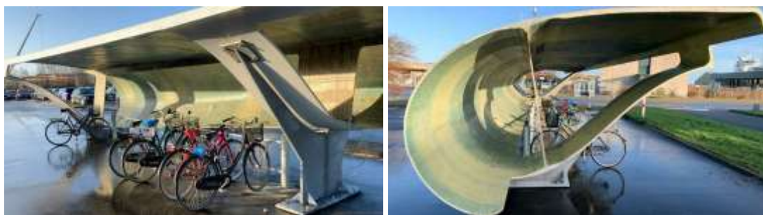
Figura 2. Bicletário na Dinamarca feito de pá eólica. Adaptado da Gamesa [2024].
