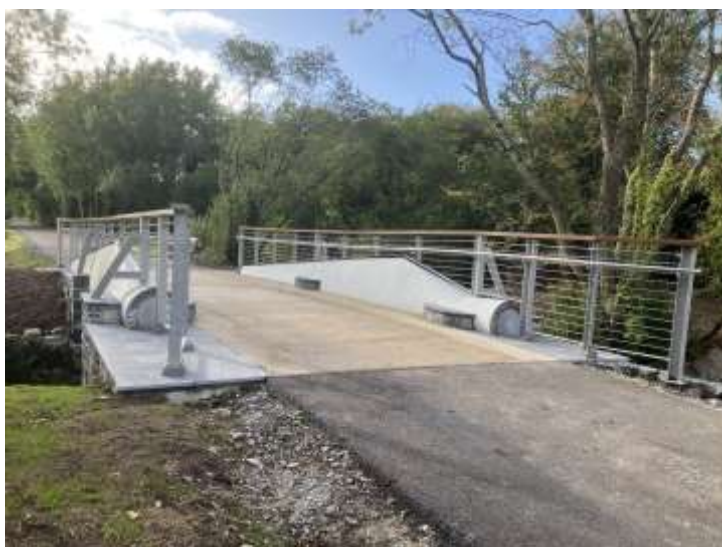
Figura 1. Duas lâminas LM13, foram usadas para substituir vigas de aço na superestrutura. Adaptado da BladeBridge [2024].
