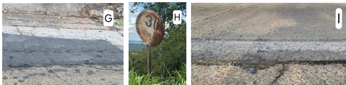
Figura 07: Irregularidades na Via: Placa danificada, assentamento e desgaste lateral
