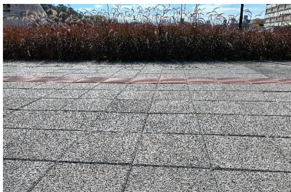
Figura 2. Revestimento com placas em concreto poroso
