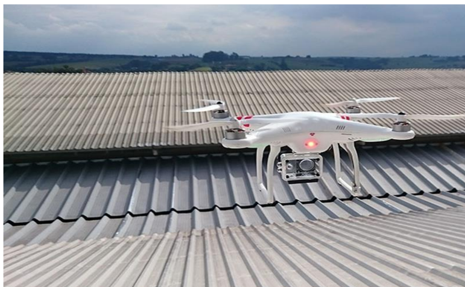
Figura 9. Inspeção predial (ARAUJO, 2018).
