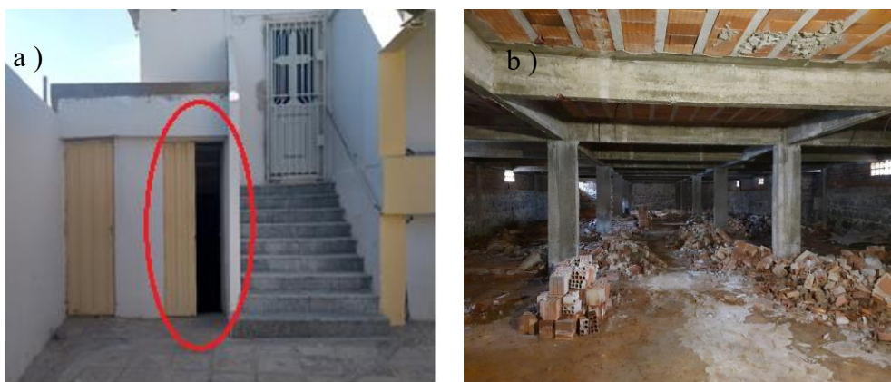
Figura 6. a) Acesso ao pavimento subsolo; b) Ambiente de estudo.
