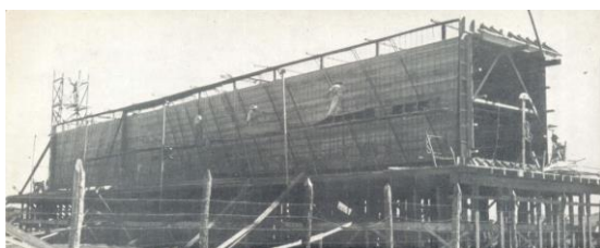
Figura 3-Construção do Museu de Brasília. Fonte: Distrito Federal, 2021. Revista Brasília, Nº28. ano 3. Abril de 1959.
