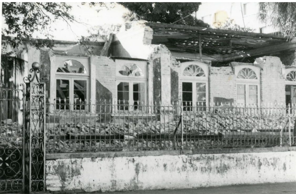
Figura 12. Demolição do edifício localizado na Rua Bispo Cardoso Ayres n.º 145, Santo Amaro. Fotógrafo não identificado, entre 1987 e 1992. Coleção Eclétismo. Acervo Fundação Joaquim Nabuco.
