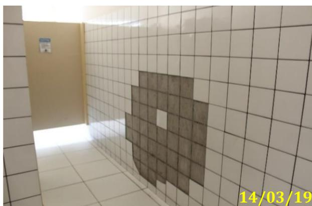
**Figura 13. Descolamento de revestimento de parede, Pró-reitoria de Pesquisa e Pós-graduação/UFRR, campus Paricarana**
