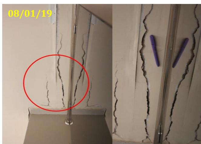
**Figura 4. Trincas no Bloco de Direito e Música/UFRR, campus Paricarana, parede.**
