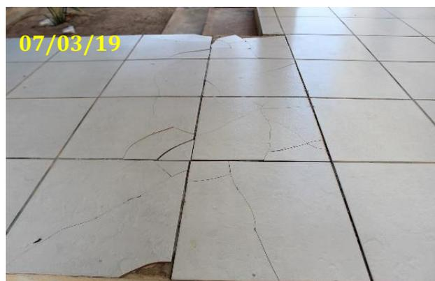
**Figura 14. Trincas e descolamento de revestimento de piso, Centro de Educação/UFRR, campus Paricarana**
