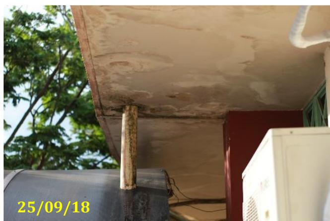
**Figura 11. Manchas de umidade (Falha no sistema de esgotamento de águas pluviais), Bloco V/UFRR, campus Paricarana.**
