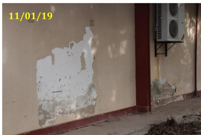
**Figura 15. Deterioração da pintura, Bloco II/UFRR, campus Paricarana.**
