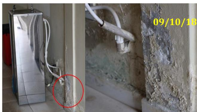
**Figura 10. Manchas de umidade (Vazamento nas instalações do bebedouro), Bloco III/UFRR, campus Paricarana.**
