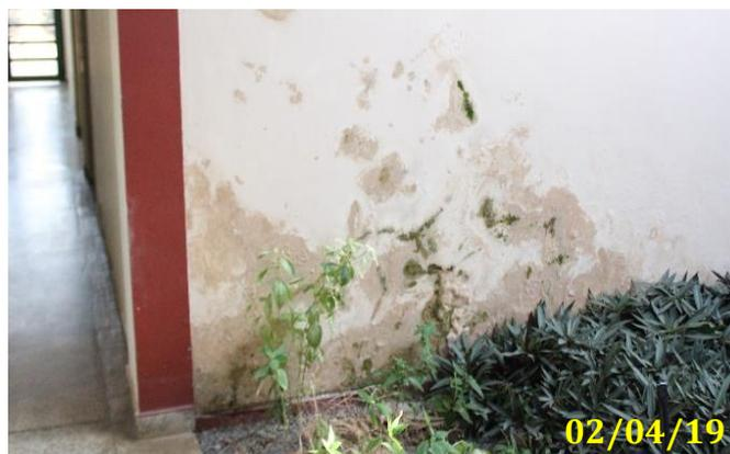
**Figura 9. Manchas de umidade (Vazamento nas instalações do banheiro), Núcleo de Pesquisas Energéticas/UFRR, campus Paricarana.**
