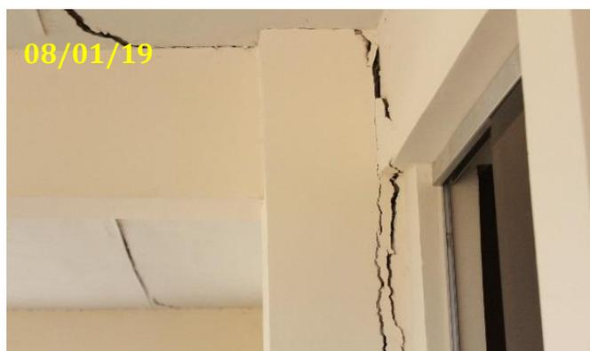
**Figura 3. Trincas no Bloco de Direito e Música/UFRR, campus Paricarana.**
