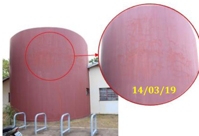
**Figura 7. Fissuras na parede externa do banheiro da Pró Reitoria de Infraestrutura/UFRR, campus Paricarana.**
