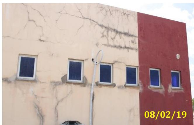
**Figura 5. Fissuras na parede do Centro de Estudos da Biodiversidade/UFRR, campus Paricarana.**
