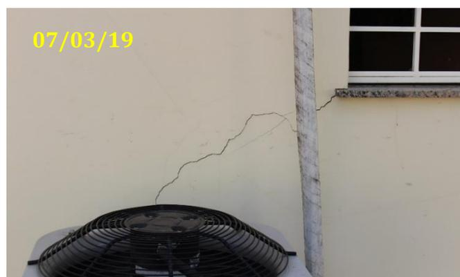
**Figura 8. Fissuras na parede do banheiro da Pró Reitoria de Infraestrutura/UFRR, campus Paricarana.**
