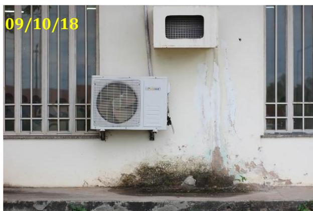
**Figura 12. Manchas de umidade (Vazamento oriundo de dreno mal instalado), Bloco III/UFRR, campus Paricarana.**
