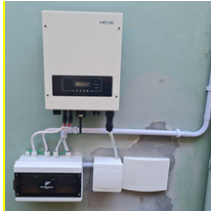
Figura 7: Sugestão de instalação do inversor
