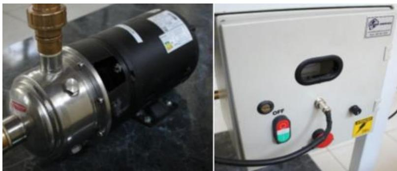
**Figura 2. Bomba marca TEXIUS modelo TMI INOX. Painel abrigo dos comandos elétricos do sistema hidráulico.**
