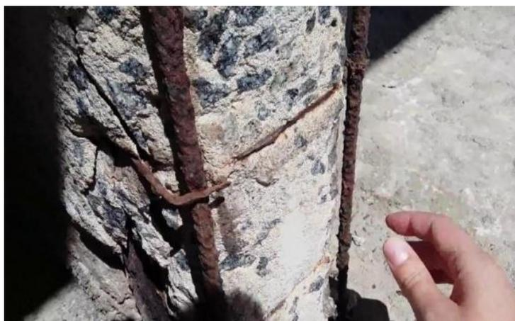
Figura 4. Corrosão na armadura do pilar
