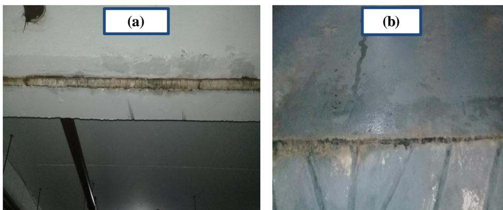
**Figura 14. (a) Goteiras no interior da viga; (b) Acúmulo de água no nível mais alto da rampa de acesso ao G2**
