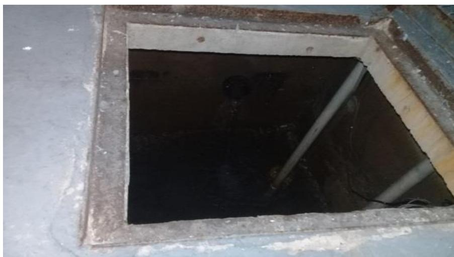
**Figura 9. Cisterna para acúmulo de água vinda do sistema de drenagem**
