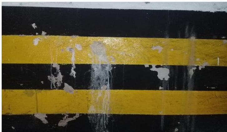
**Figura 17. Eflorescências na parede do 2º subsolo (G2)**
