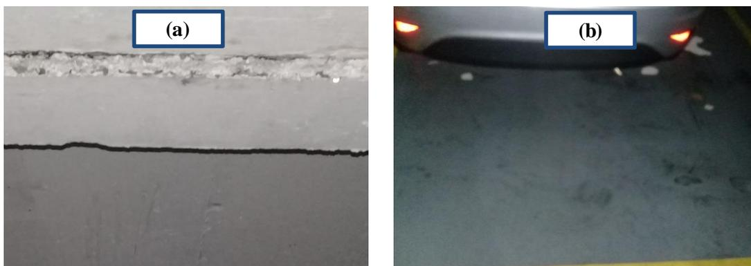
**Figura 20. (a) Goteiras em uma das vigas no G2; (b) Acúmulo de água decorrente de goteiras**
