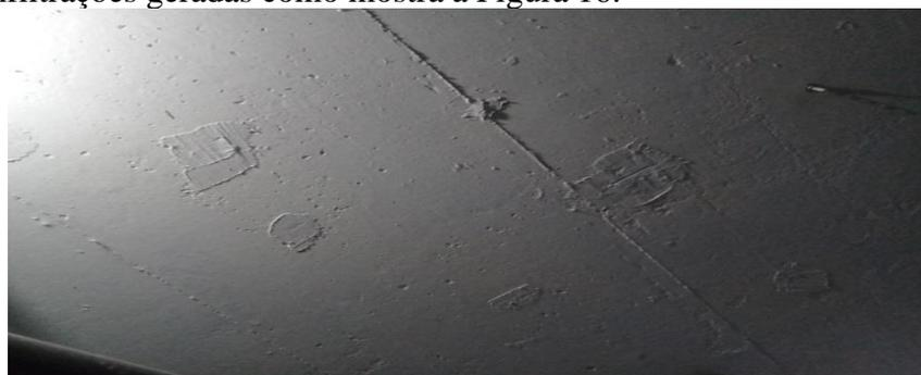
**Figura 16. Tamponamento de infiltrações com massa forte e aditivo impermeabilizante no teto da garagem**
