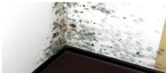
Figura 3. Presença de mofo em parede interna
