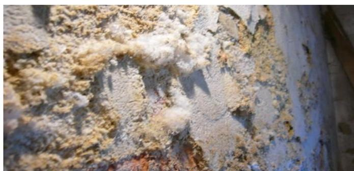
Figura 6. Criptoflorescência em parede
