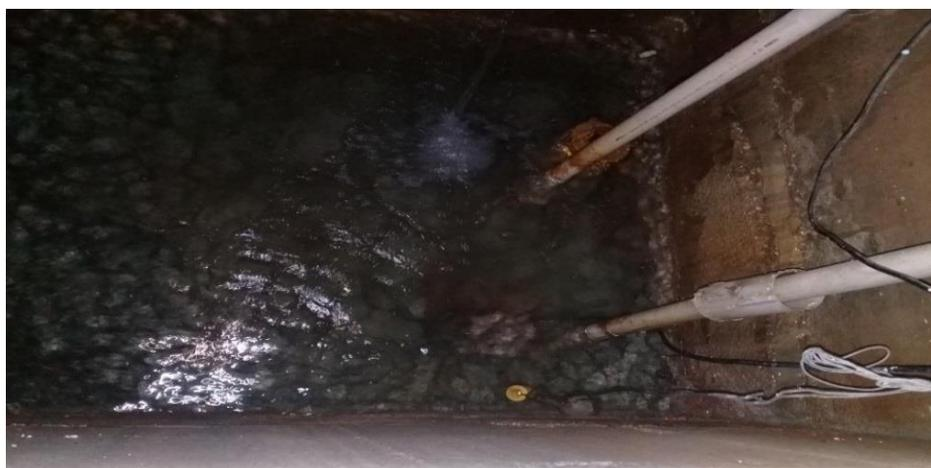
**Figura 10. Bombas submersas de sucção do edifício Rio Mondego**
