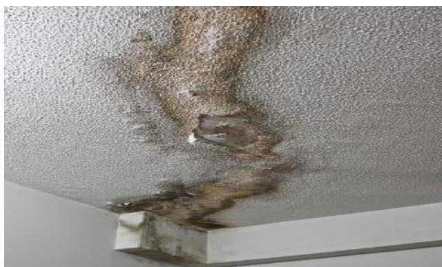
Figura 2. Manchas no teto provocadas por goteira
