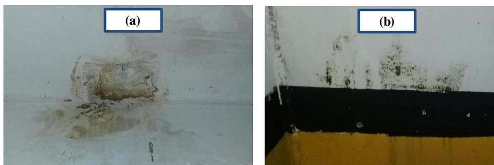
**Figura 18. (a) Manchas no teto; (b) Mofo encontrado na parede**
