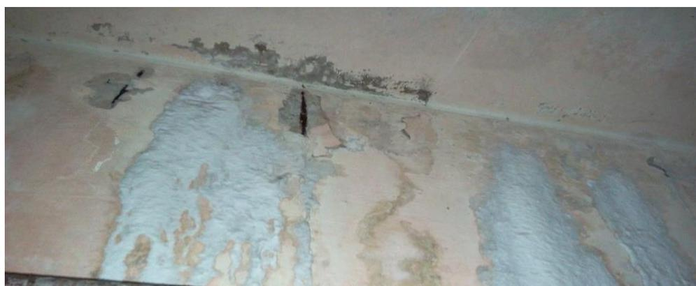
Figura 5. Eflorescência na superfície de paredes com pintura
