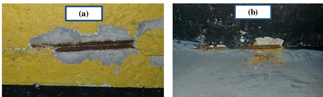
**Figura 19. (a) Corrosão da armadura do pilar; (b) Oxidação da armadura**
