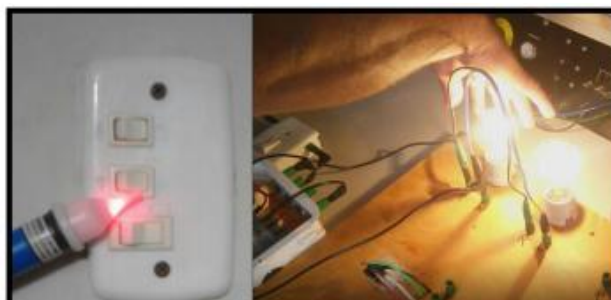
Figura 6. Testes de ausência ou presença de tensão.
