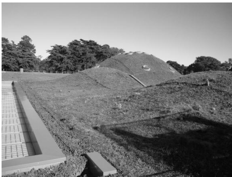
Figura 7. Áreas Onduladas do Telhado Verde da Academia de Ciências da Califórnia.
