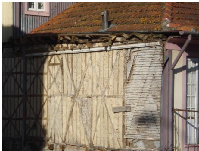
Figura 3. Taipa em parede externa – Centro Histórico do Porto - Portugal. Foto: Cybelle Miranda, 2013
