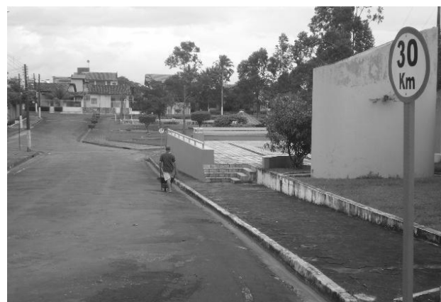
FOTO 04 – Av. Principal do Residencial San Marino. Fonte: Trabalho de Campo, 2009.
