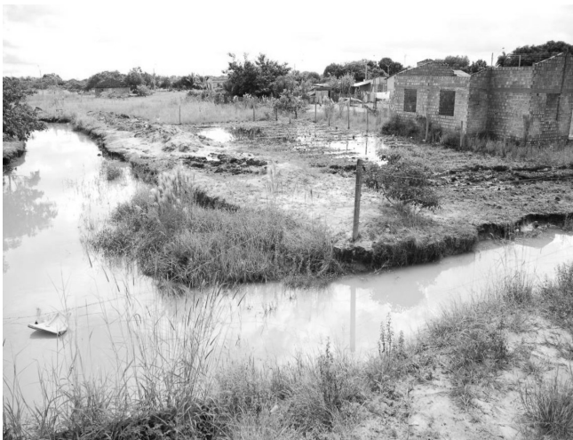
FIGURA 09 - Construção de casas em trechos pantanosos no bairro Senador Hélio Campos. A drenagem destes trechos tem sido realizada no sentido de viabilizar a ocupação do local. Contudo, este tipo de intervenção apresenta efeitos pouco satisfatórios durante a estação úmida. Fotografado por Carlos Sander, junho de 2008.
