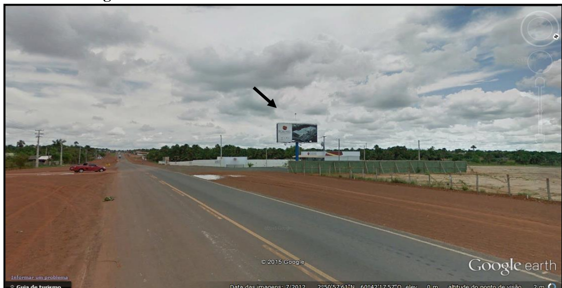
Figura – 5. Trecho urbano da rodovia BR-174 - 2012
