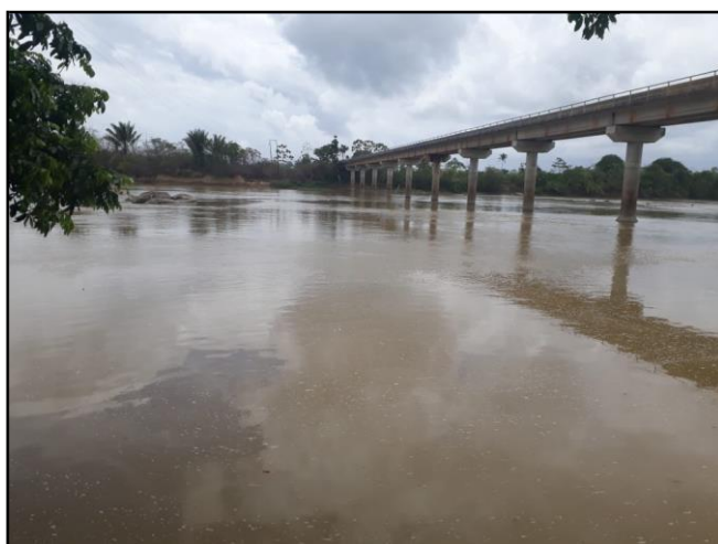
Figura 05 - Ponte sobre o rio Mucajaí, Alto Alegre-RR Fonte: Acervo dos autores, 2019.
