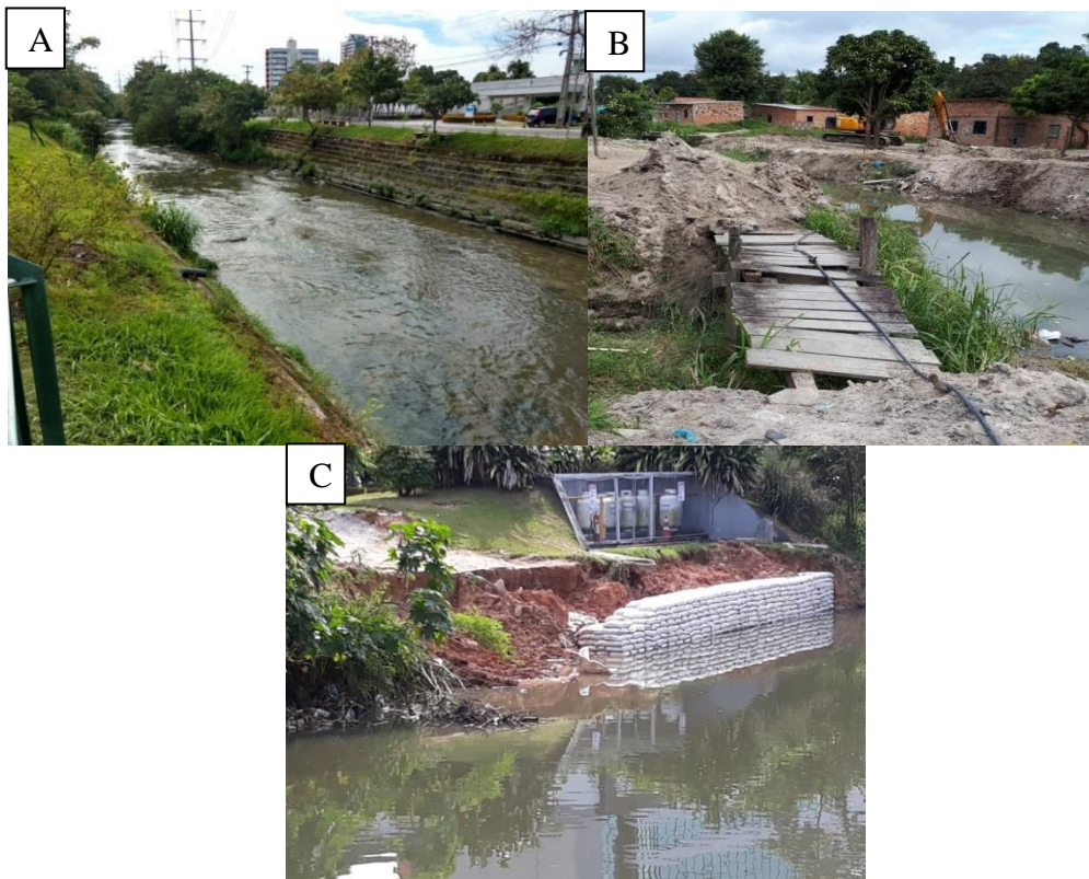
Figura 5 a: Retificação do canal, médio curso do igarapé do Mindu. Figura 5 b: Igarapé após o processo de dragagem, nota-se a máquina ao fundo da imagem. Figura 5 c: Contenção (Regionalmente chamado de Rip-Rap ) para mitigar os efeitos da erosão fluvial, Baixo curso do igarapé do Mindu. Fotos: Os autores, 2018.
