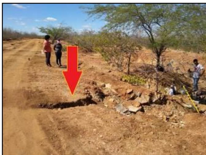
**Figura 10** - Presença de ravinas ligando a estrada e a voçoroca. Fonte: Autores
