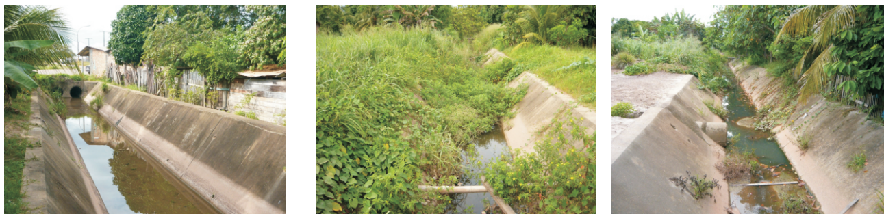
Figura 8 - Igarapé São Lázaro (a). Pontos de assoreamento (b). Vegetação no canal (c).
