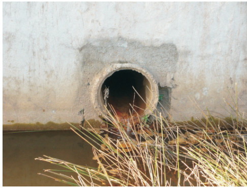
Figura 5 - Esgoto desaguando no rio (a). Tanques de esgotamento sanitário “Buraco da Prefeita” (b).
