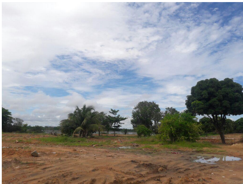
Figura 1: Vista parcial do Beiral após a demolição das primeiras casas. Fonte: Rosa Filho 2018
