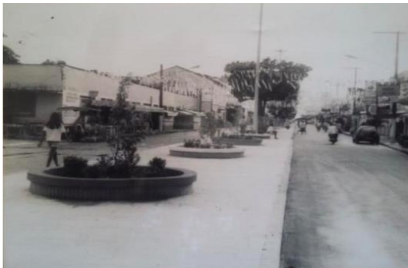
Figura 3 – Trecho da Avenida Amazonas após a reforma de 2000. Fonte: Arquivos do Jornal Novo Horizonte , 11 de jul. de 2000.
