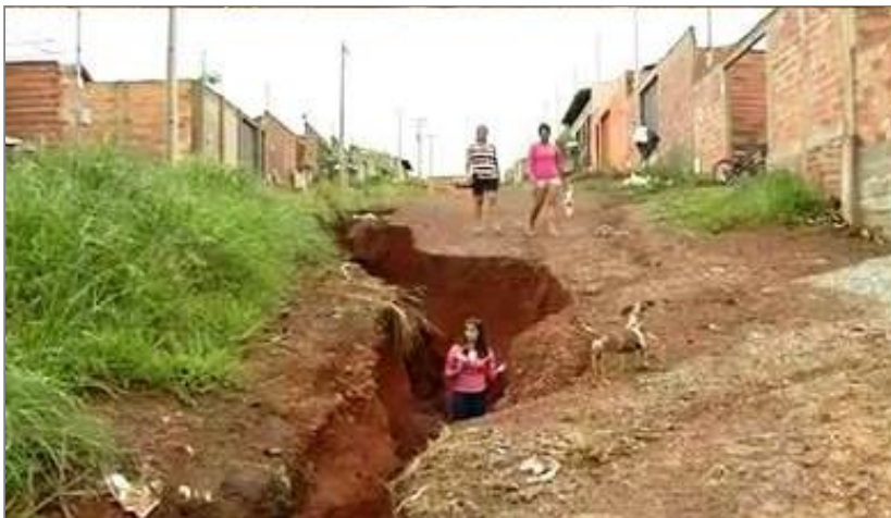
Figura 9 - Profundidade da feição erosiva no bairro Real Conquista, Goiânia, 2016. Fonte: G1 Goiás, 2016.
