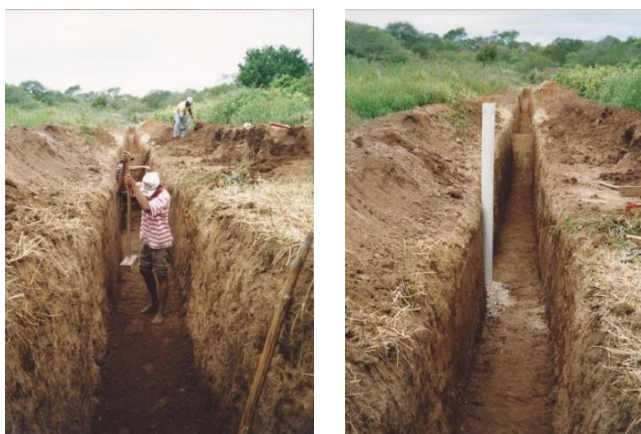
Figuras 15 e 16: Vala socada e acomodação de brita e cano para verificação da quantidade de água. Fonte: Pesquisa de campo (Fevereiro de 2005).
