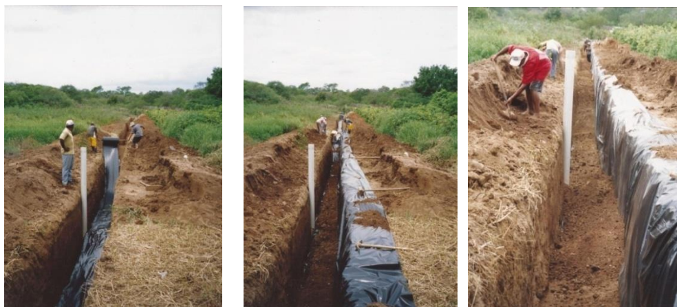
Figuras 17, 18 e 19: Instalação com acomodação da lona de plástico preto e fechamento da vala. Fonte: Pesquisa de campo (fevereiro de 2005).
