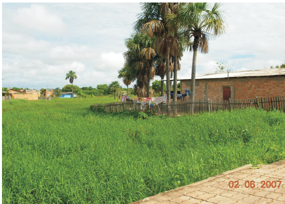
FIGURA 13: Residência construída praticamente “dentro” do canal do igarapé.
