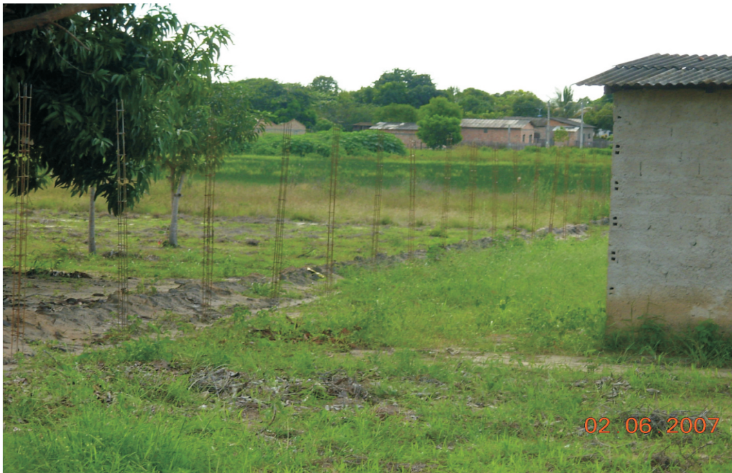
FIGURA 14: Muro sendo construído dentro de um dos lagos da nascente. Fonte: Acervo de João Theófilo Rocha Pereira, Alysson Rogers Soares Macedo e Antonio Tolrino de Rezende Veras, 2007.
