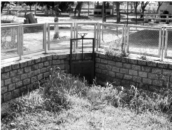
Figura 15: Pequena comporta que regula a saída de água do lago do Parque Anauá para o Igarapé Mirandinha. (Tonello, 2006).
