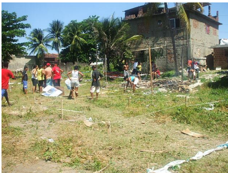
Figura 05: Parcelamento de uma ocupação para a construção dos primeiros barracos Fotografia: o autor (2010)
