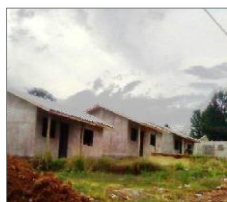
Figura 2 - Construção de habitação social no Bairro São Francisco
